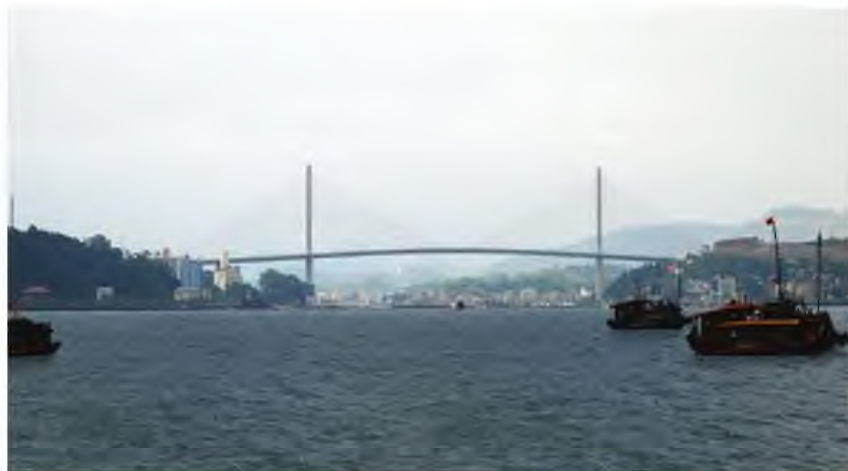
Cầu Bãi Cháy (Nguồn: https://commons.wikimedia.org )
